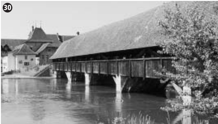
Die Wangenbrücke , erbaut in der heutigen Form im Jahr 1552, führt in Wangen über die Aare und bildet mit dem schmucken Ort eine städtebauliche Einheit. Die Brückengeschichte ist seit 1367 belegt. 1406 fiel Wangen an die Berner, und der erste Landvogt erhielt den Auftrag, eine gedeckte, neue Brücke zu bauen. Die Holzjoche wurden in der Folge immer wieder durch Hochwasser, Eisgang und Flösserei beschädigt, so dass Mitte des 16. Jh. eine Verdoppelung der Spannweiten zwischen den Jochen
