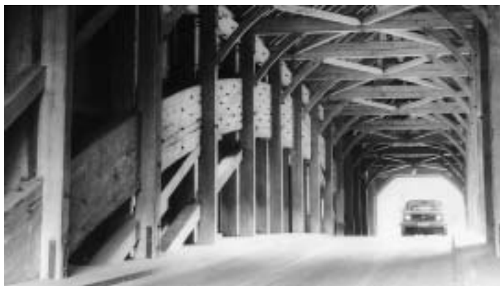
Innenansicht der Hasle-Rüegsaubrücke
