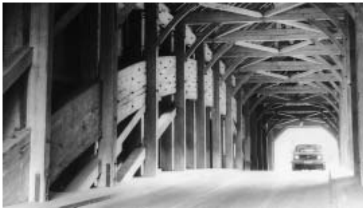
Vue intérieure du pont de Hasle-Rüegsau
