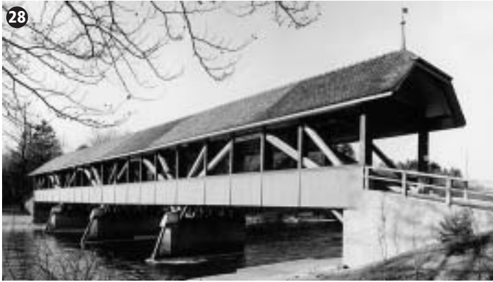
Die Auguetbrücke , erbaut 1836, vor der Verschiebung Hunzikenbrücke genannt, führt zwischen Belp und Muri über die Aare. In Folge des Anschlussneubaus der Kantonsstrasse an die Nationalstrasse A6 Bern–Thun wurde sie 1974 erneuert und 4 km flussabwärts versetzt.
